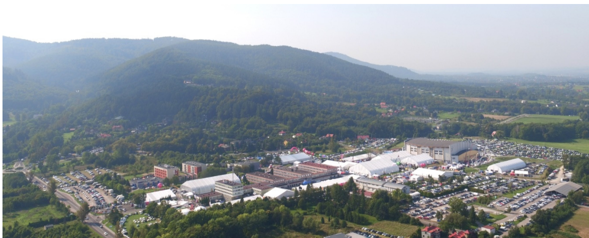
Fot. 1. Widok na teren targów ENERGETAB 2016 z lotu ptaka
