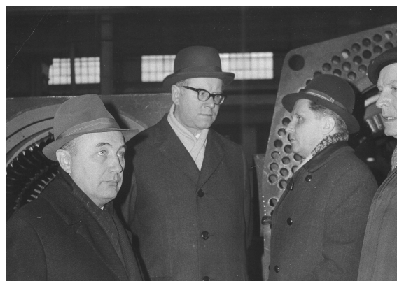
Fot. 3. Wizyta ekspertów w Dolnośląskich Zakładach Wytwórczych Maszyn Elektrycznych DOLMEL
