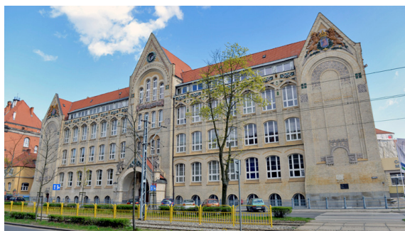
Fot. 3. Gmach przy ul. Sikorskiego 37 obecnie
