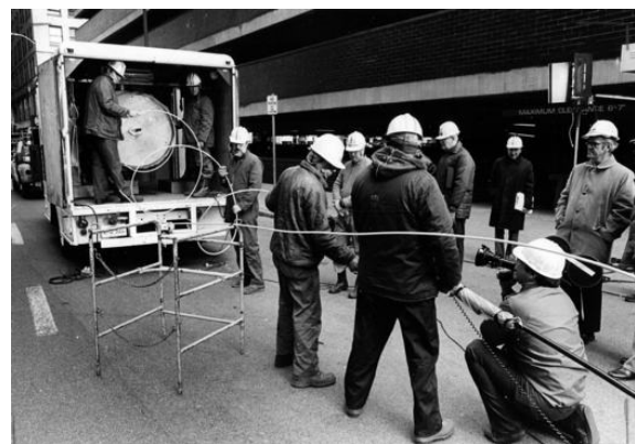
Rys. 10. Budowa pierwszego komercyjnego światłowodowego systemu komunikacyjnego przez firmę At&T w 1977 roku w Chicago [10]
