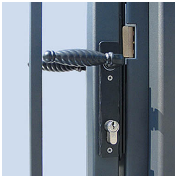
Fot. 1. Zamek furtki posesyjnej otwierany elektromagnesem, znajdującym się za zatrzaskiem, widocznym po prawej stronie klamki wg [2]
