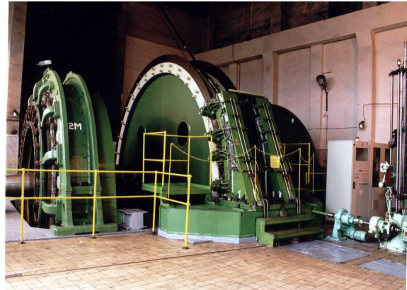
Fot. 5. Maszyna wyciągowa kop. Rydułtowy szyb Leon
