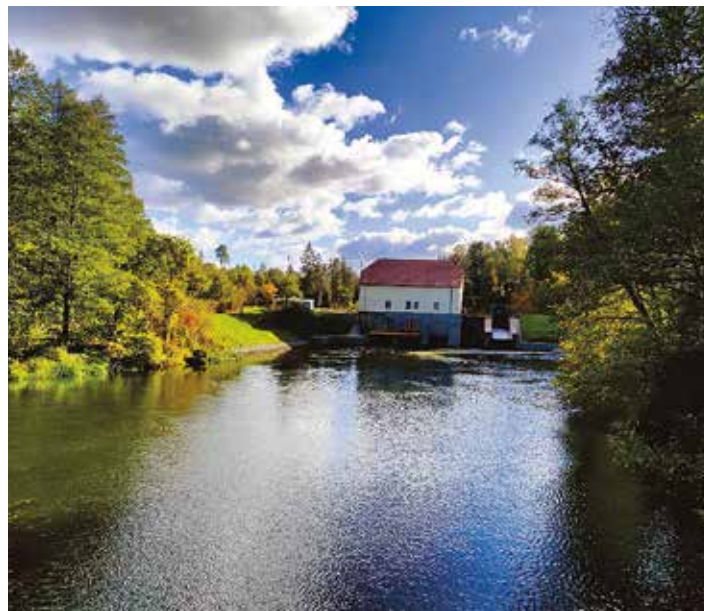
Elektrownia wodna „Łyna”, foto: Hanna Szemiot
