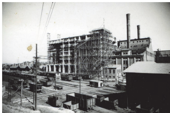
Rys. 6. Budowa nowej kotłowni, 16 VIII 1944 r.
