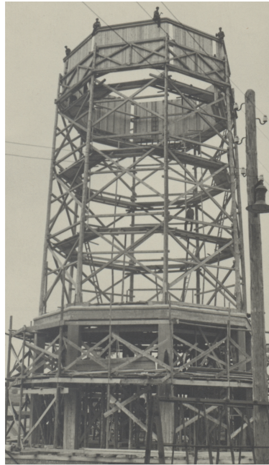
Rys. 4. Budowa drewnianej chłodni kominowej
