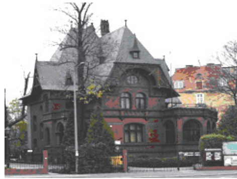
Rys. 7. Dom Technika w Legnicy
