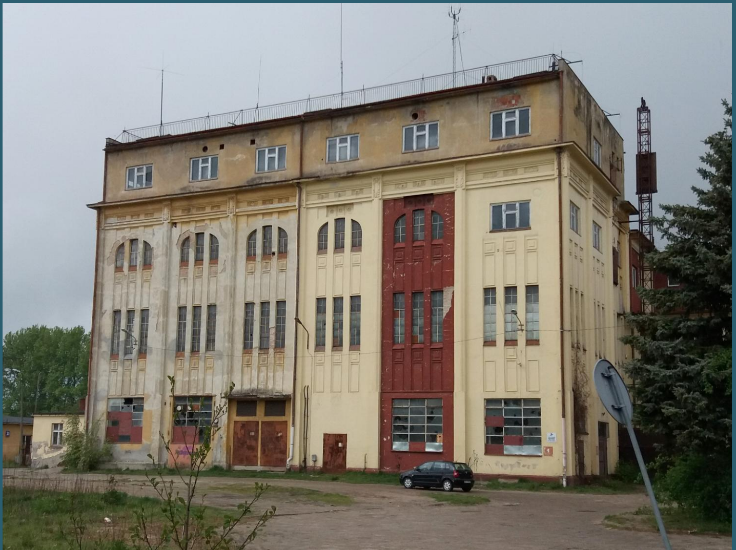
Po największej elektrowni węglowej Pomorza środkowego w Białogardzie pozostał tylko budynek. 2021.
