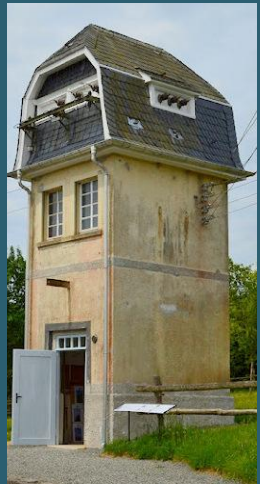
Piękny przykład wieżowej stacji transformatorowej
